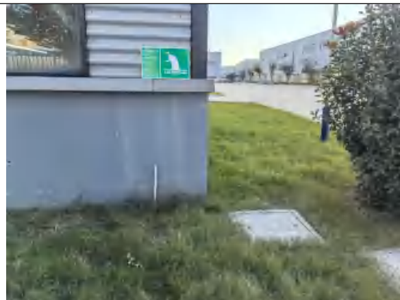
雨水排口及标识牌
