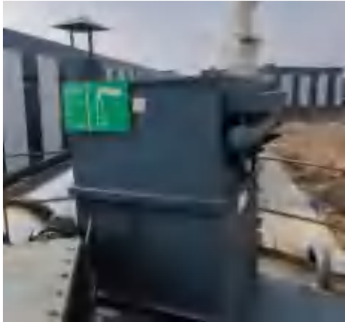
废气治理装置及排气筒 DA005
